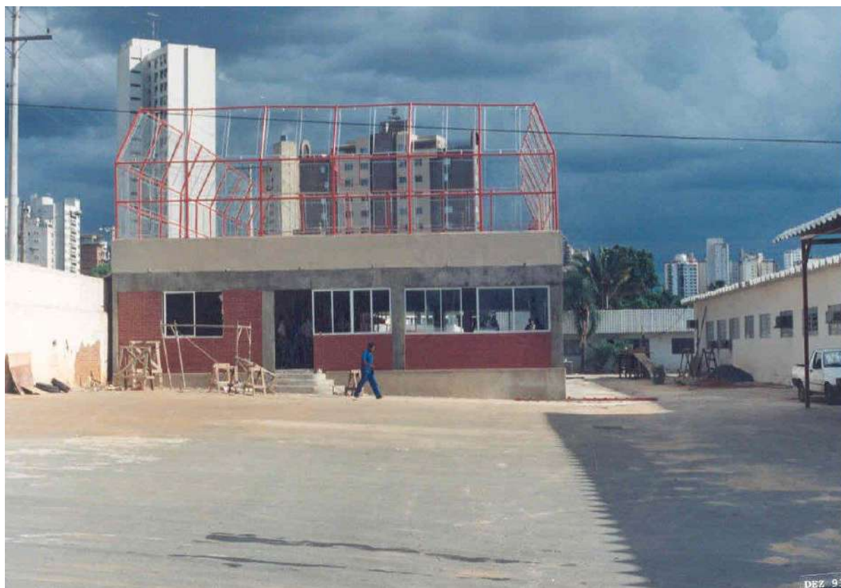
Figura 1.3 – Obras do Grupo de Resgate Pré-Hospitalar.
