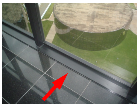
Figura 62 – Peça metálica entre o suporte dos vidros e a laje.
