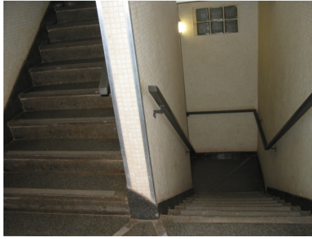
Figura 65 – Exemplo de escada
