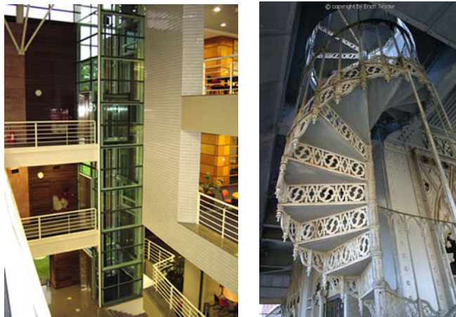
Figura 64 - Fosso de elevador e escada facilitam a movimentação da fumaça na edificação
