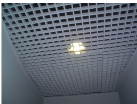
Figura 56 - Exemplo de forro de metal perfurado
