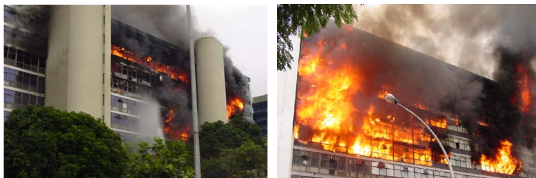
Figura 67 - Incêndio generalizado no prédio do INSS, Brasília-DF, 2005
