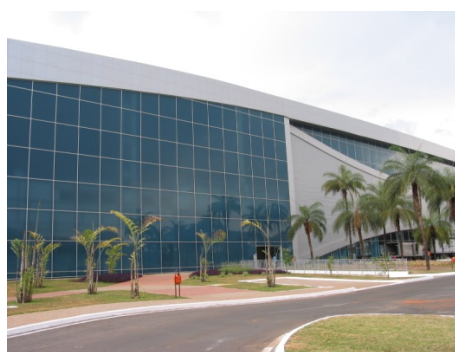
Figura 63 - Prédio com fachada em vidro laminado - Centro de Convenções Ulisses Guimarães
