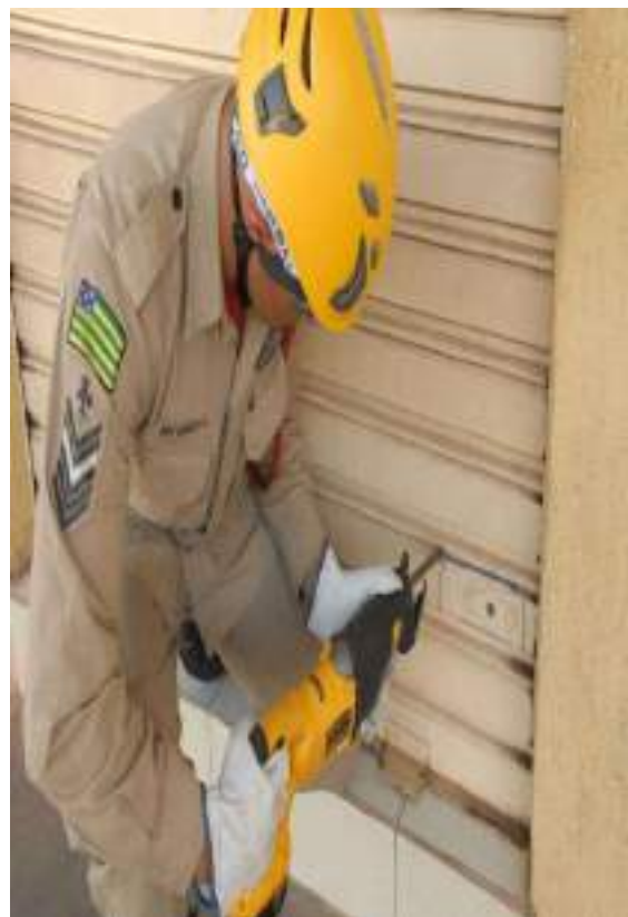
Figura 4.42 – Corte em volta da fechadura com serra sabre (Fonte: Comissão)
