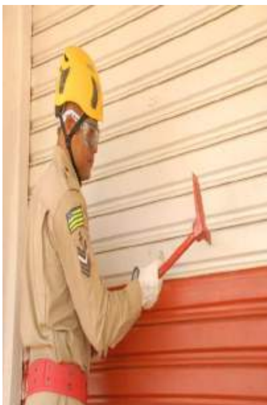
Figura 4.38 – Perfuração da porta para acesso e corte dos varões (Fonte: Comissão)
