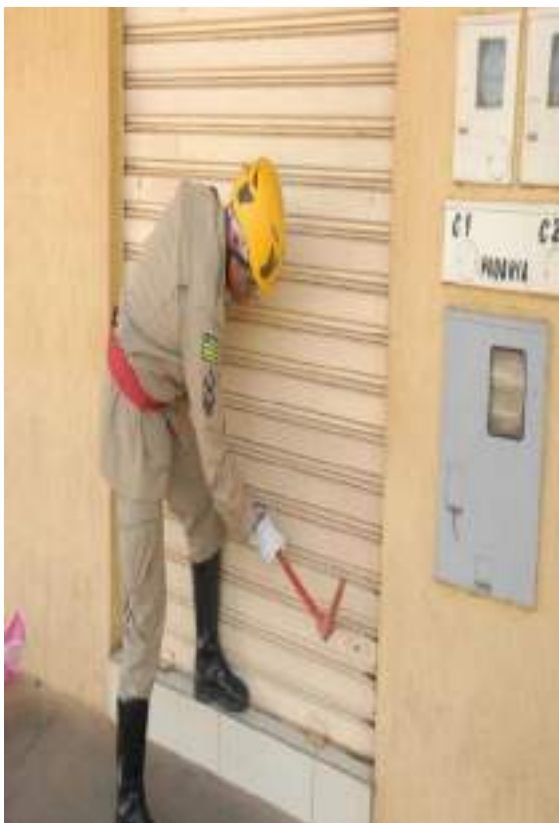
Figura 4.41 – Perfuração da porta para inserção do serra sabre (Fonte: Comissão)
