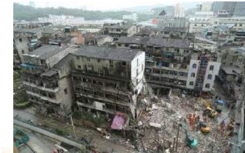
Figura 3.10 - Dano nível severo
