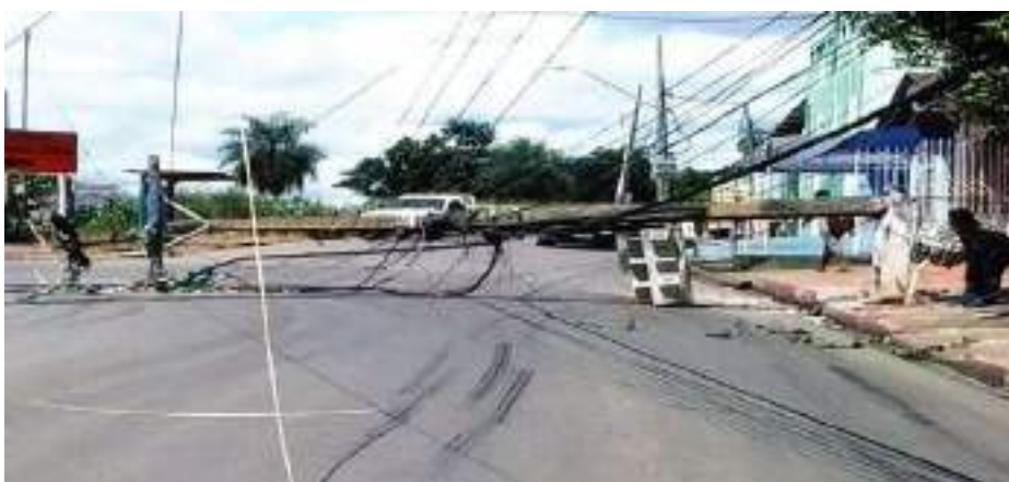
Figura 4.1 – Acidente com eletricidade (Fonte: g1 Globo)
