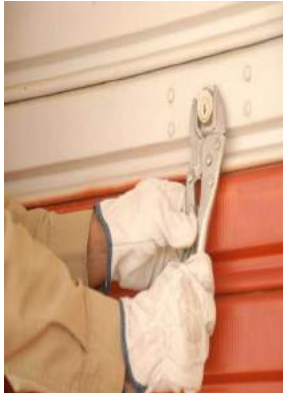
Figura 4.36 – Retirada do cilindro com alicate de pressão (Fonte: Comissão)
