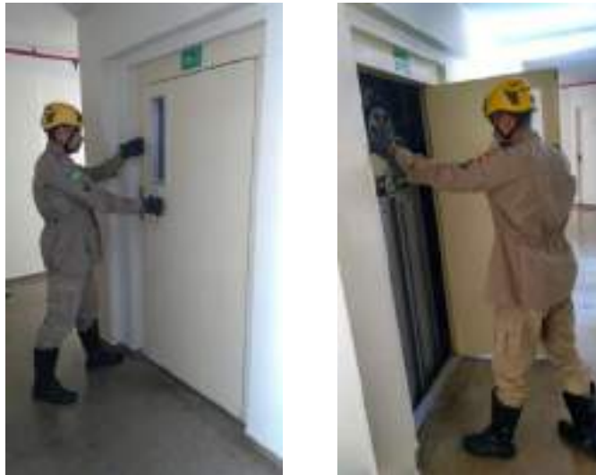
Figuras 3.2 e 3.3 – Abertura da porta do pavimento com chave específica (Fonte: Comissão)
