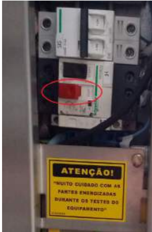
Figura 3.10 – Realizar o desligamento da chave geral (Fonte: Comissão)
