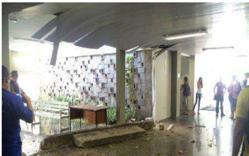
Figura 3.8 - Dano nível leve (Fonte: JC Oline, 2015. Disponível em: < http://jconline.ne10.uol.com.br/ >. Acesso em: 05 mai. 2017)
